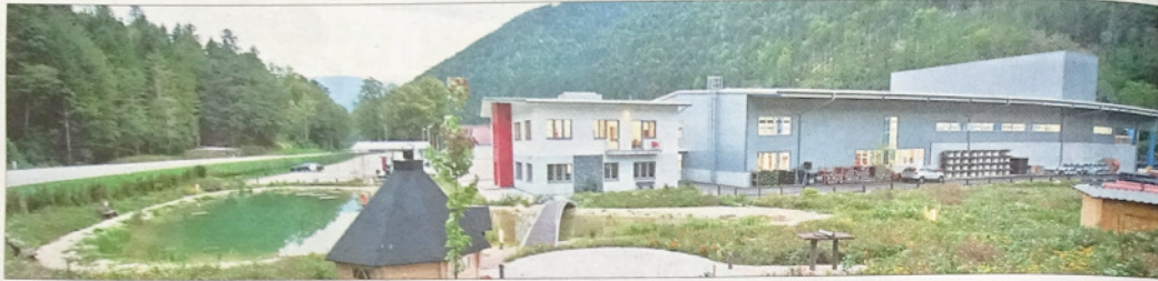
In der Gesamtansicht zeigt sich die Dimension der neu errichteten Halle 3 und des Bürobaus mit dem vorgelagerten Teich.
