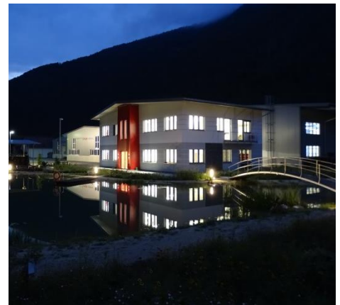
Neues Bürogebäude, Adresse Walcherbauer 18 in 3343 Hollenstein an der Ybbs.
